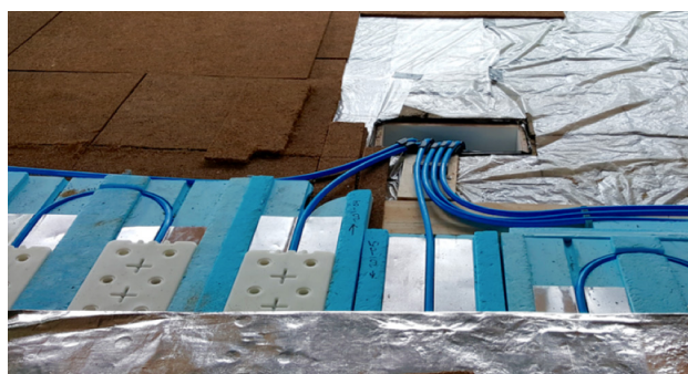
Figuur 19: Foto vloerbouw
