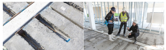
Figuur 21: Foto vloeropbouw (a) en type verbinding (b) Tijdelijke Rechtbank
