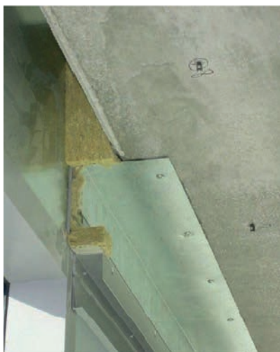
Figuur 9.6: Aansluiting schort
