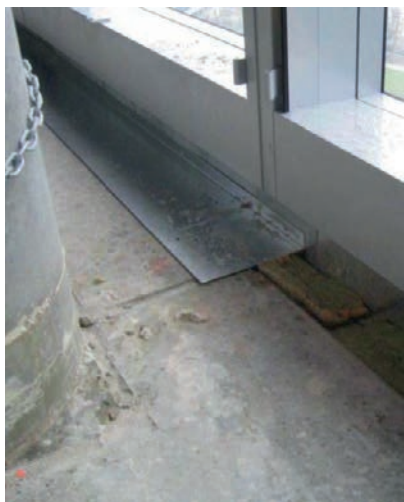
Figuur 9.5: Aansluiting borstwering
